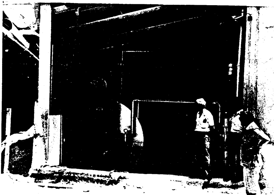
CAMARA DE COMBUSTIÓN
